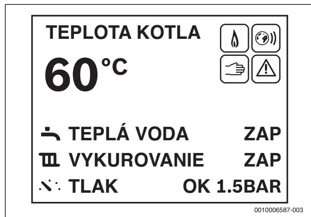
Obr. 5 Štandardné zobrazenie prevádzkového tlaku vykurovania
